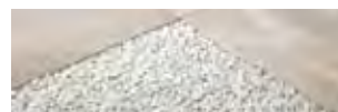
POSA A SECCO SU GHIAIA La posa su ghiaia permette il perfetto drenaggio delle acque piovane.
